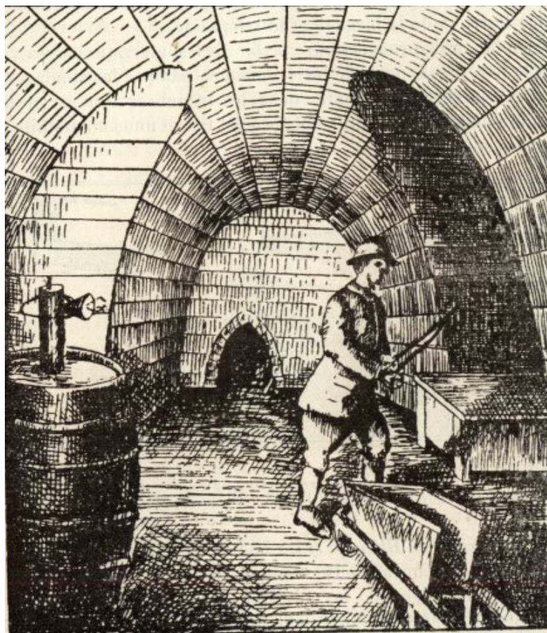
Fig. 7. - Souterrain du chateau Boutmy, à Bellacourt. Au fond ouverture ogivale
